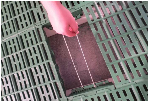
Abb.18 Drahtbügel in die in den Tragleisten platzieren!
